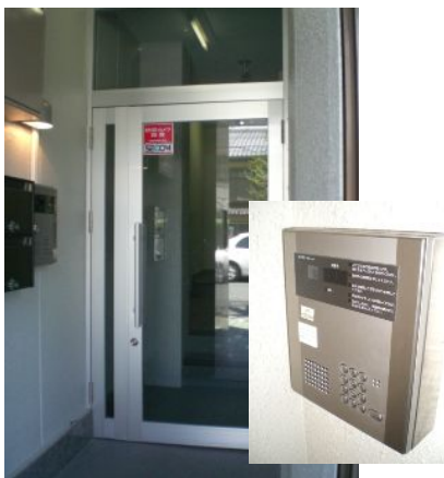
施工例①: 各部屋にモニター付のカメラ内蔵型
