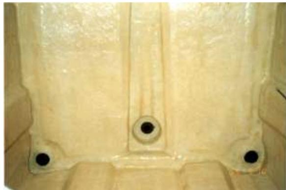
貯水槽(受水槽・高架水槽)は時間の経過とともに①の写真のように汚れます。清掃をすれば②の写真のようにきれいになります。
