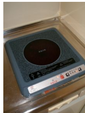
ラジエントヒーター 取替え
