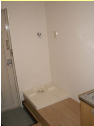
洗濯機置き場を キッチン横に設置。
